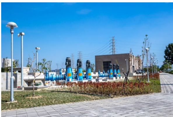
台南園區第六配水池工事完了
