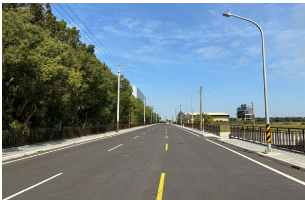
南 137 拡幅工事現場写真
