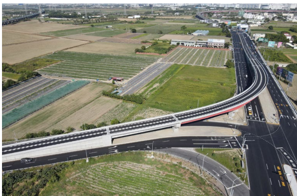
新港社大道方向転換工事現場写真
