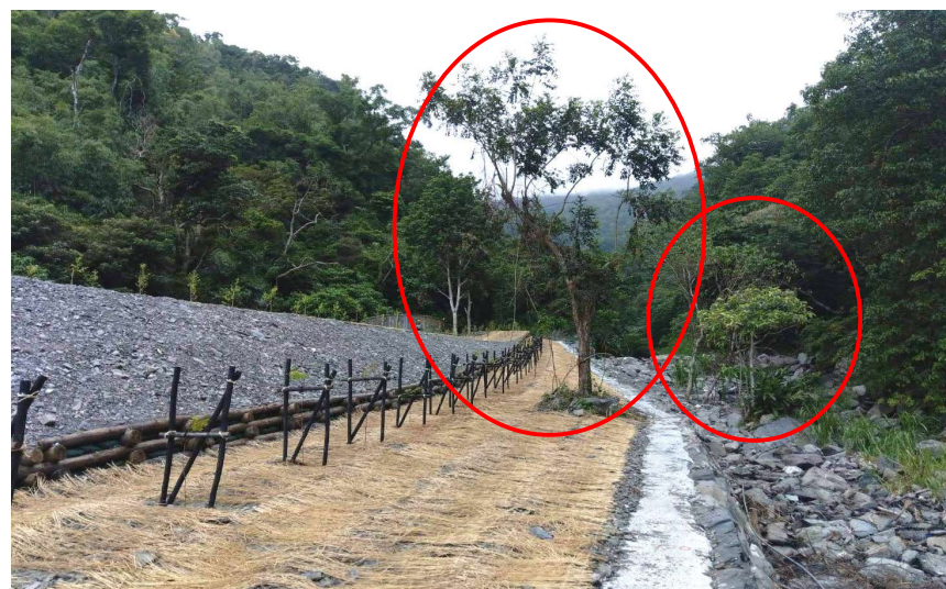
護岸以多孔隙高透水設計，採現地石材、木格框擋土牆、保留現地樹種、並配合植栽復育
