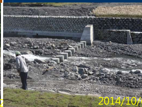
低落差固床工與砌石護岸
