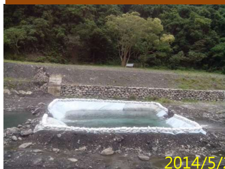
沉砂池控制濁度
