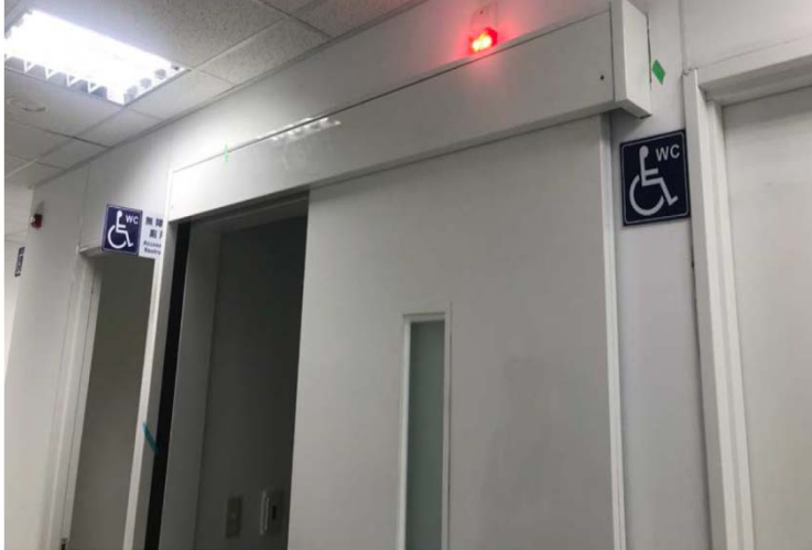
緊急求助鈴與連接 之蜂鳴器接電測試
