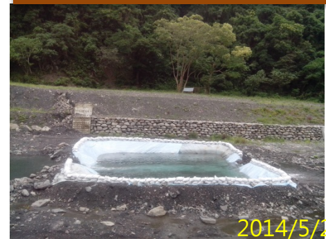
沉砂池控制濁度
