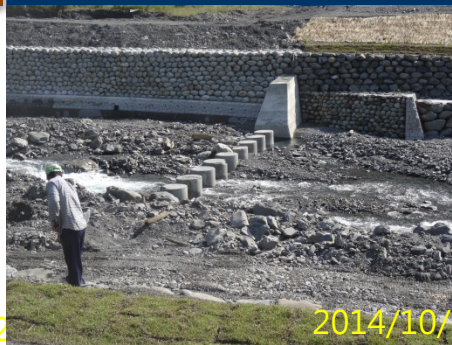
低落差固床工與砌石護岸
