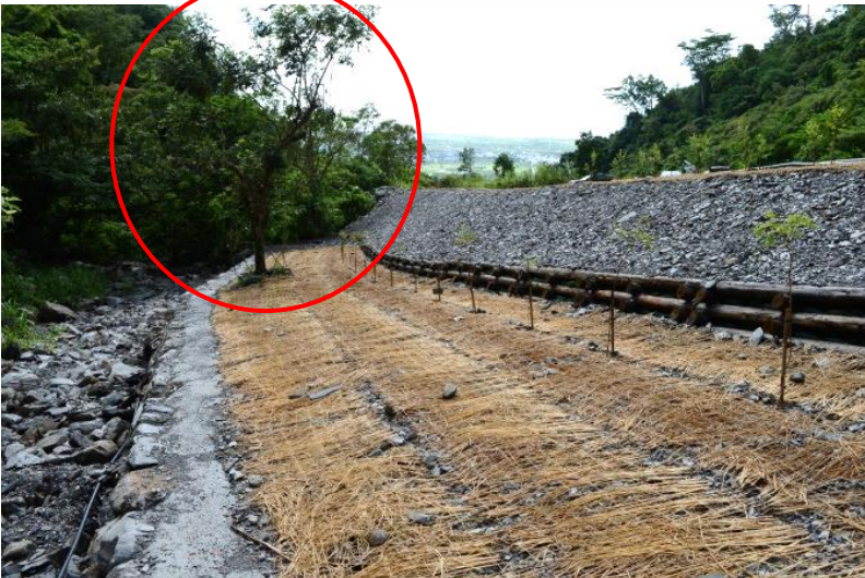
護岸以多孔隙高透水設計，採現地石材、木格框擋土牆、保留現地樹種、並配合植栽復育
