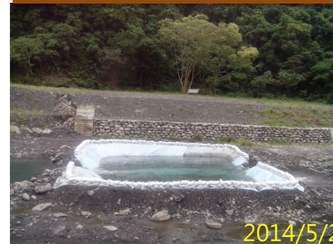
沉砂池控制濁度
