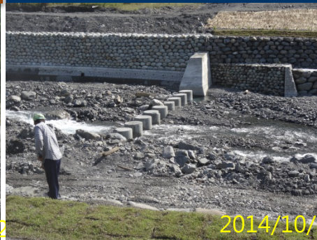
低落差固床工與砌石護岸
