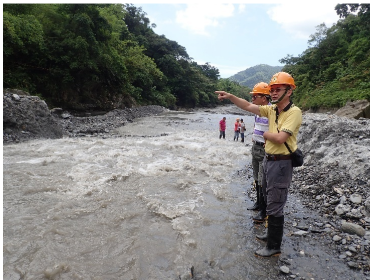
施工現地討論工程影響 及後續工序規劃與調整
