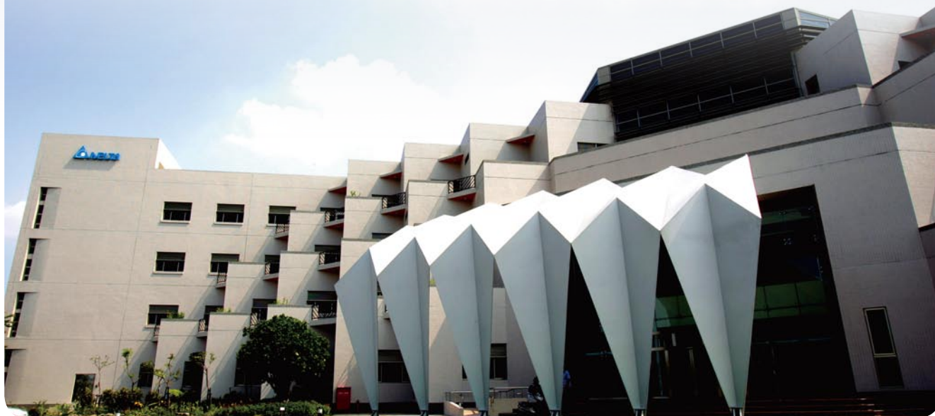
■ 台南園區のグリーン工場—台達電第1期工場
