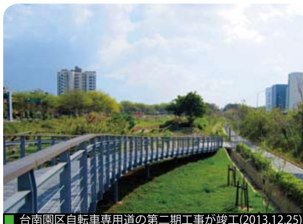
■ 台南園區自転車専用道の第二期工事が竣工(2013.12.25)
