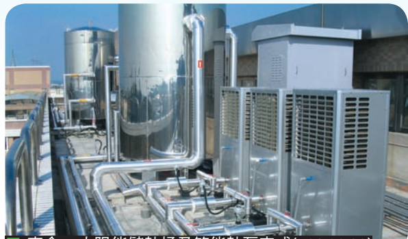
宿舍5T太陽能儲熱桶及節能熱泵完成(102.06.28)
