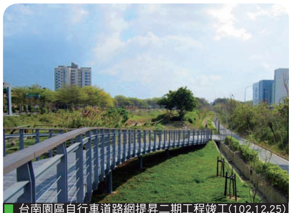
台南園區自行車道路網提昇二期工程竣工(102.12.25)
