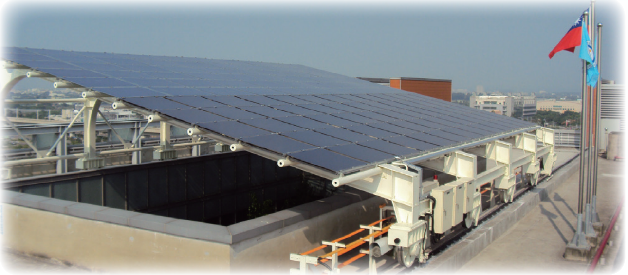
■ 台南園區的行政大樓天井太陽能光電裝置，將帶來節能減碳之效 ( 101.01.10 )
