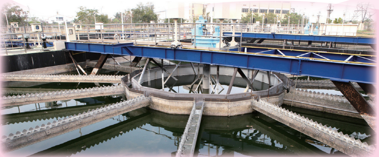
■ 高雄園區污水廠一期二階工程完工 ( 101.04.16 )
