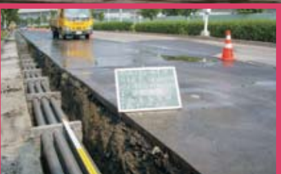
台南園區97年度寬頻管道新建工程完工
