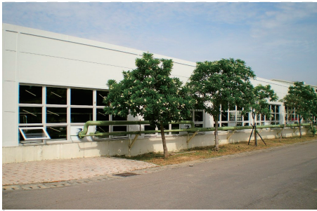
▲污水處理廠曝氣池加蓋工程完工後外觀
