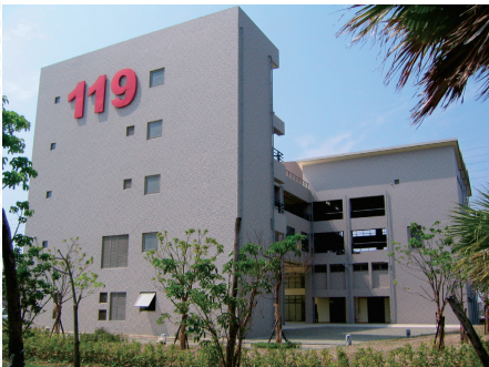
▲位於台南園區的消防隊舍，使園區安全更有保障
