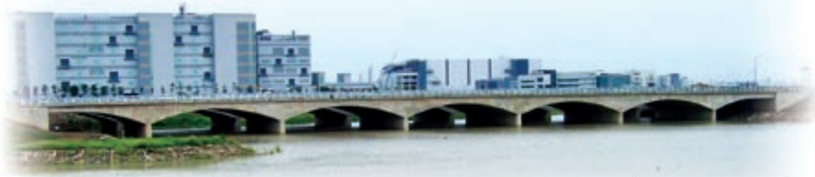
台南園區西北区第2分区南科九路に箱型ブリッジが完成
