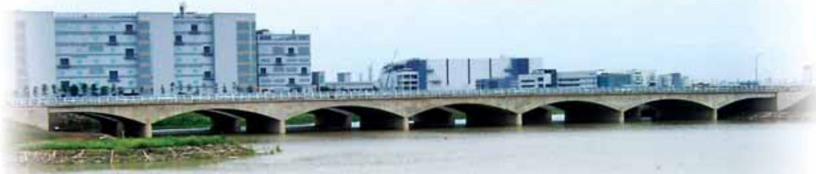
台南園區西北區第2分區南科九路變段面箱型橋樑完工
