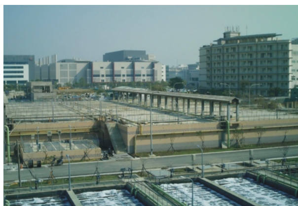
台南園區污水處理廠二期工程
