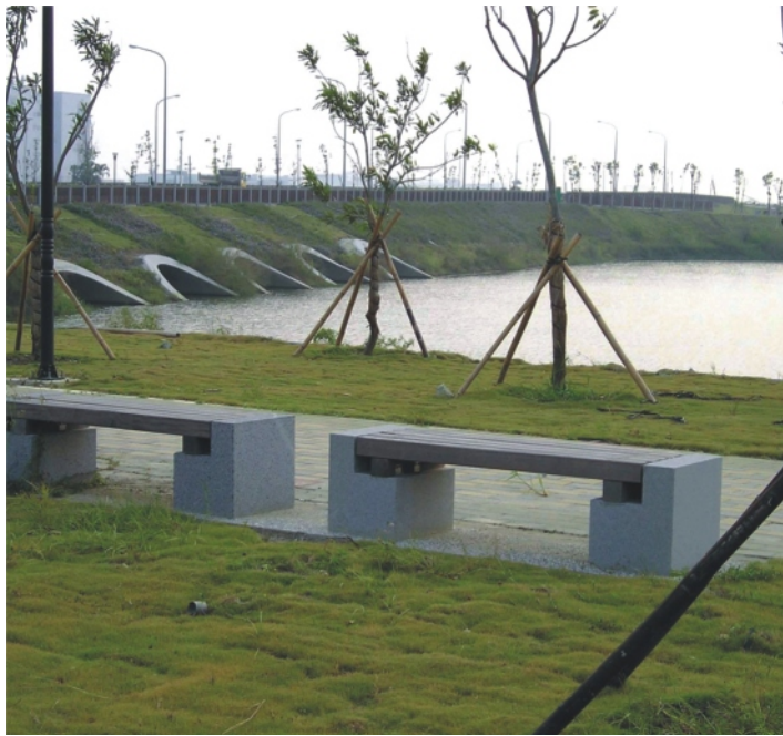
新建40米道路下五孔涵拱連接南北兩側滯洪池體
