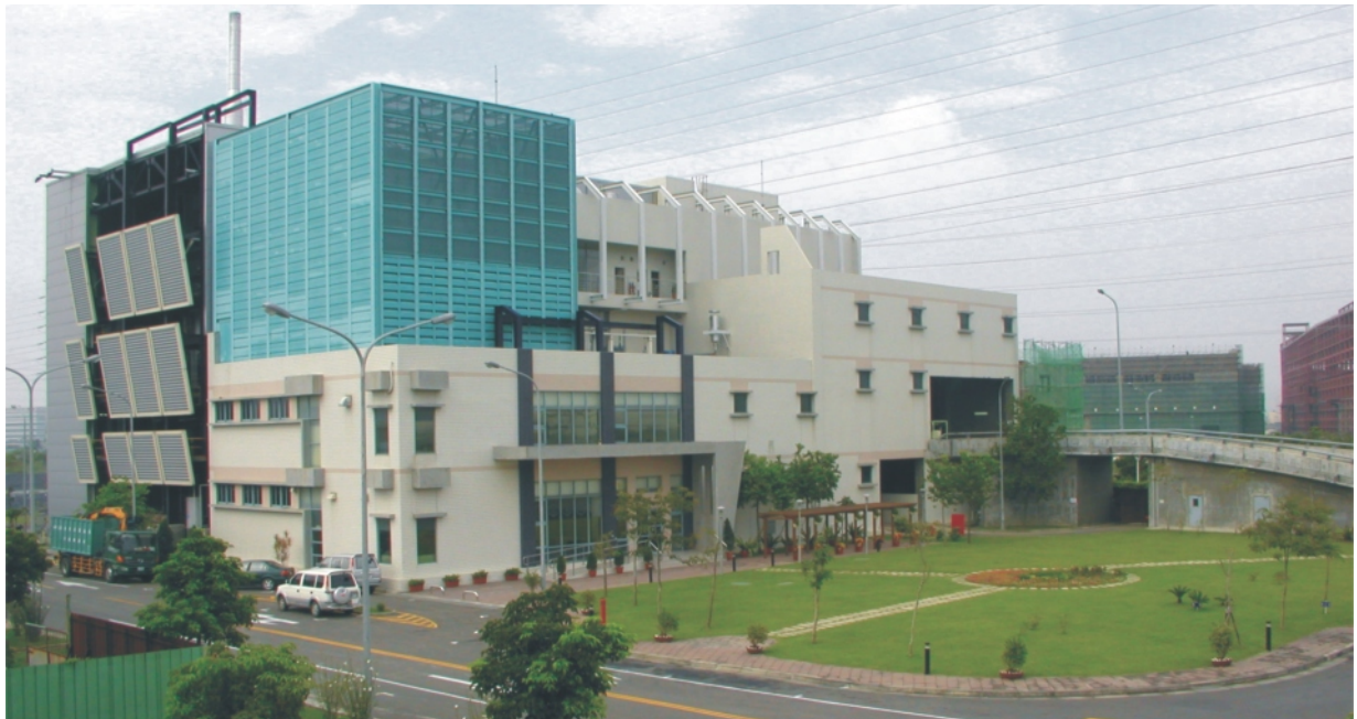
台南園區資源再生中心
