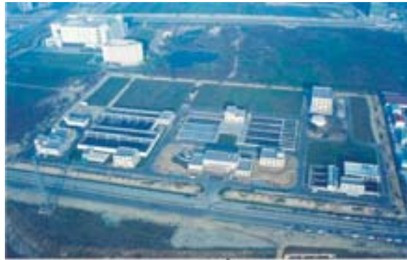
図 5-3-1 環工センター（污水処理場）
