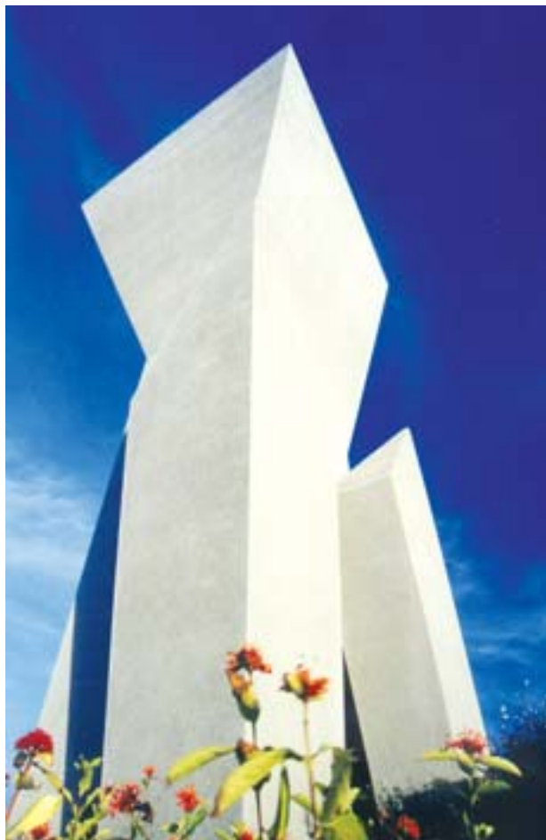
図 2-4 台南園区生活用水給水塔
