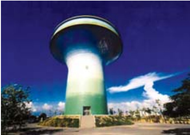
図 2-3 台南園区工業用第一給水塔
